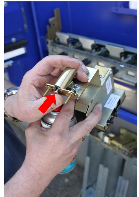
Funktionsprüfung des Kondensators:
